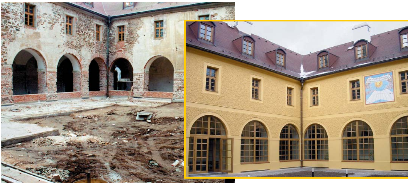
Nádvoří zámku Hejnice před a po sanaci
