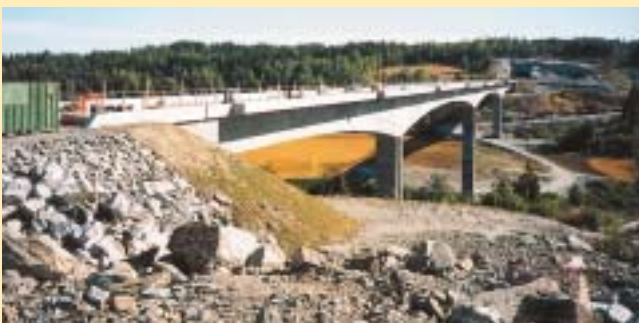
Most Holendalen tvoří část železniční tratě mezi Noskem a Švédskem
