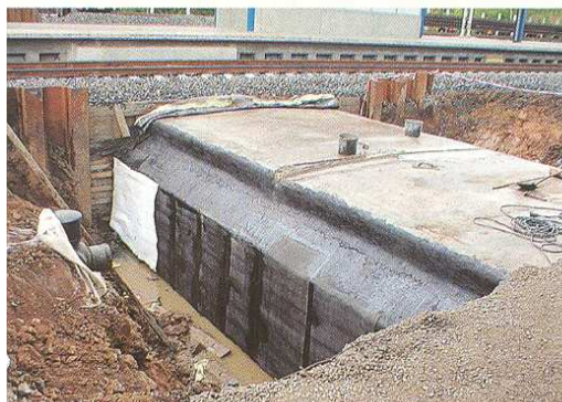
Konstrukce podchodu s novou izolací
