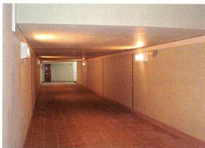
Podchod po opravě
