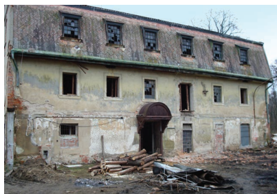
Původní stav objektu
