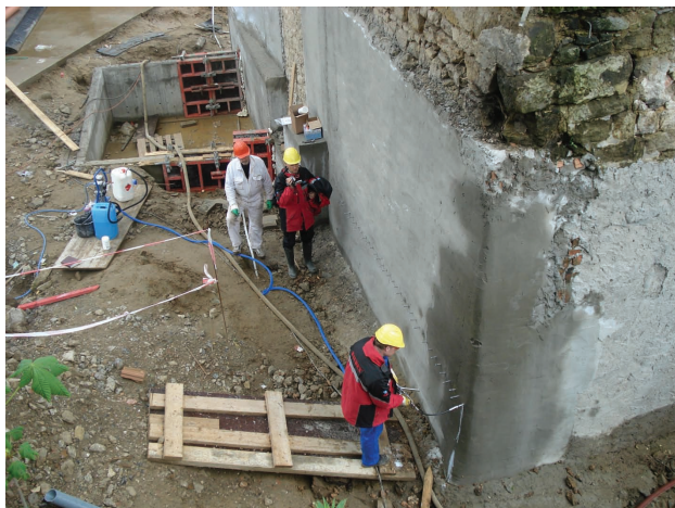
Provádění tlakové injektáže akrylátgely
