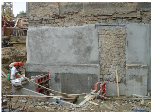
Příprava pro hydroizolační sendvič
