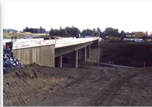
Svrchní stavba mostu Keverndalen – 1.500m 2 Norsko
