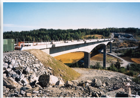
Železniční most Holendalen Norsko – 6.000 m 2
